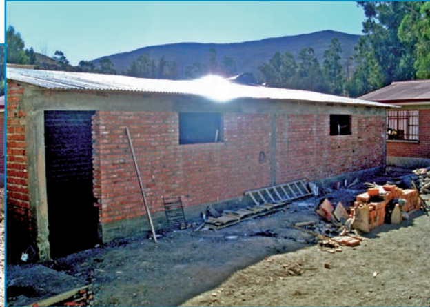
het dak zit dicht
