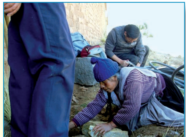
Bij al onze projecten werken de begunstigden (of hun ouders) mee, zoals hier bij de aanleg van de waterleiding in Chiutara Baja.
